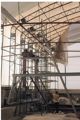
図 13 施設の解体 蓋石取り上げ用の自走式クレーンと大型テント倉庫の内幕を解体している様子
